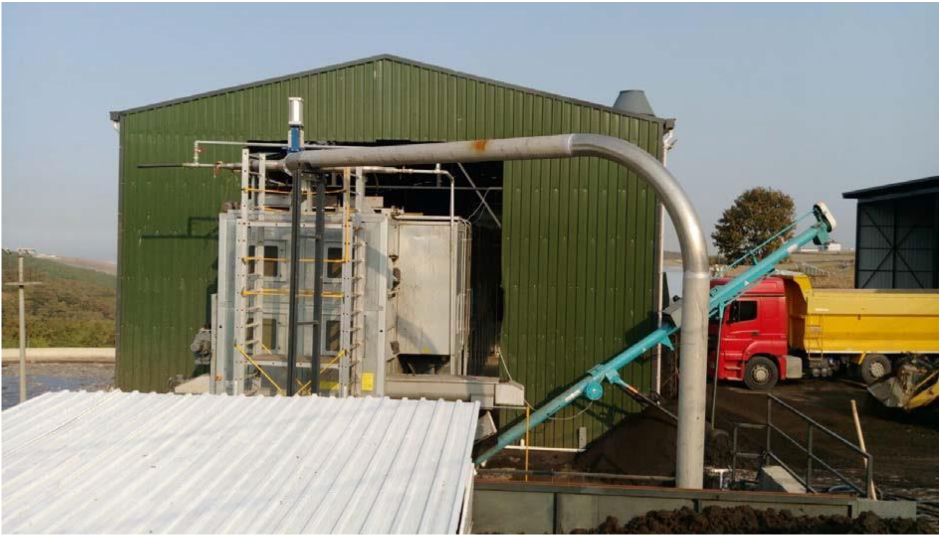
Kurutma Tesisi Çamur Girişi
