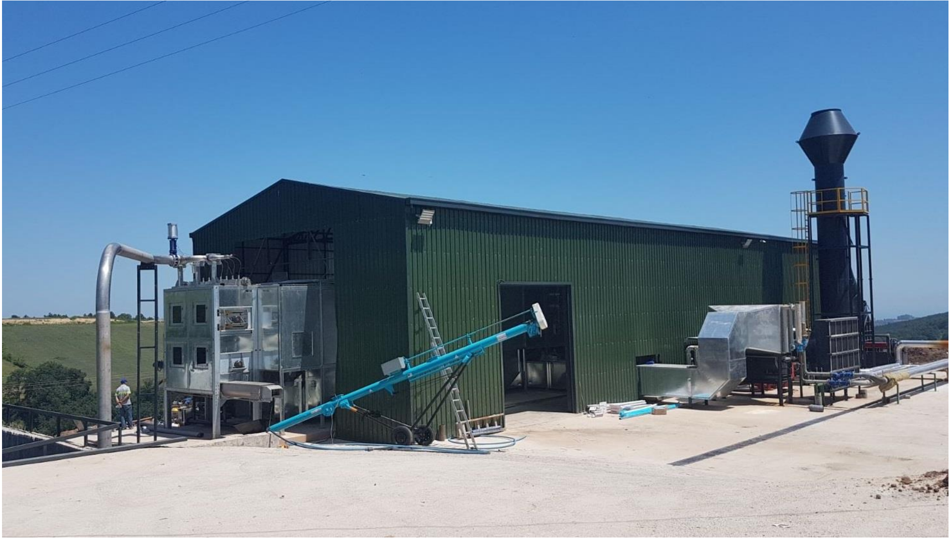
Kurutma Tesisi Genel Görünüşü
